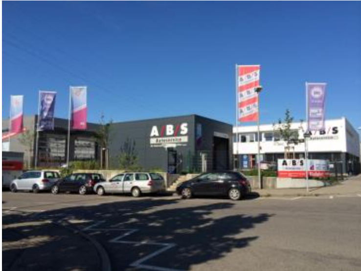
Außenansicht von A/B/S in Stuttgart
